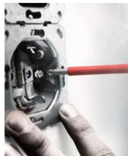
Unerlässlich für den Einsatz bei Reihenklemmen, Sicherungskästen, Schaltern, Relais etc.: Die Profilkombination aus Schlitz und Phillips bzw. Schlitz und Pozidriv.
